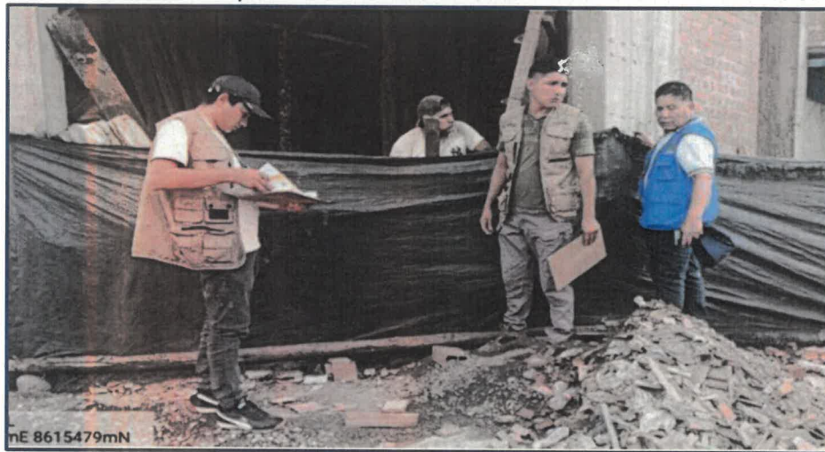
Ilustración 21: Supervisión de Administrados en el rubro de Construcción
